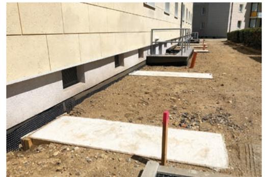
**In der Elsa-Fenske-Straße 9-15** werden die alten Balkone durch moderne und größere Balkone ersetzt. Dazu werden zunächst die alten Kragplatten abgesägt und die alte Vorhangfassade teilweise zurückgebaut. Nachdem eine verbesserte Wärmedämmung angebracht wurde, können im Herbst die neuen Balkon montiert werden.
