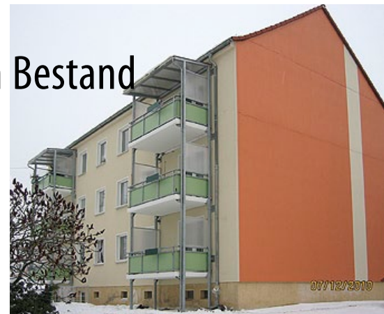
Die neue Fassade – An der Silberspitze 32 (Sanierung 2010)
