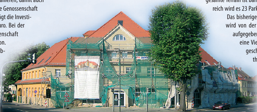
Das Gebäude im August 2008
